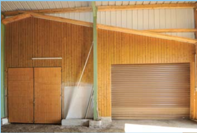
▲ Porte bois sur gonds ou rails. Porte métallique à enroulement électrique + télécommande à distance.
